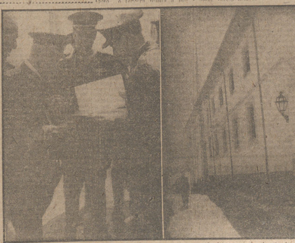
El gobernador militar, general Aranguren, firma, en nombre del Capitán general, el acta de recepción del nuevo pabellón para infecciosos construido en el Hospital Militar. A la derecha, vista del nuevo y magnífico edificio. (Fots. SANZ).
