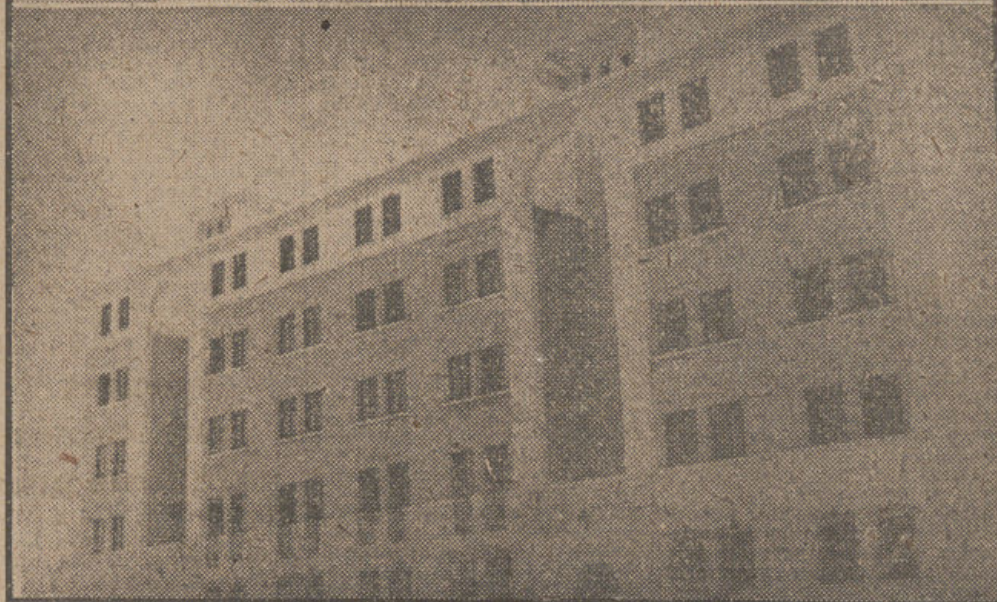
Arriba: el Capitán general de la región, don Emilio Esteban-Infantes, haciendo entrega a sus be- neficiarios de las llaves de las veinte viviendas que para suboficiales de la guarnición han sido construidas en la carretera de Pulianas por el Servicio Militar de Construcciones. Abajo: el nuevo bloque de viviendas inaugurado. (Fots. SANZ).
