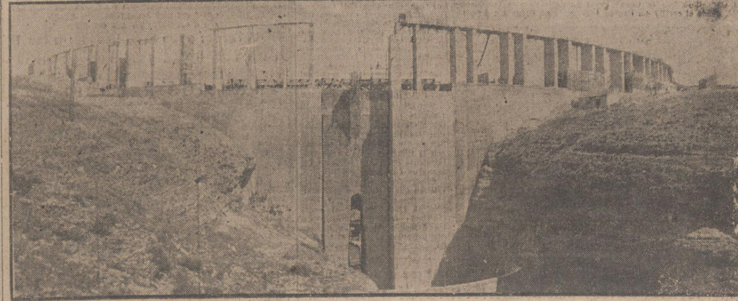
Presa del pantano de Los Bermejales, en el que se aprecia la parte superior, que en la actualidad está terminándose de completar de hormigón. (Fot. C. H. G.)
