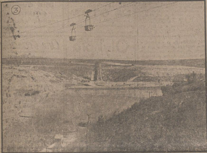
Vista parcial de las obras del pantano de Cubillas. Presa de tierra y teleférico. Al fondo, la torre de toma de agua del embalse.—(Fot. C. H. G.)
