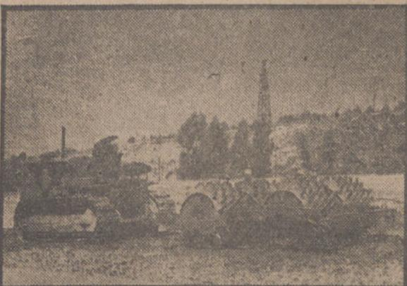
Uno de los rodillos especiales que aplenan las sucesivas capas de tierra que constituirán la presa. — (Fot. C. H. G.)
