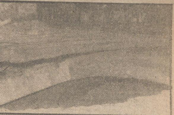
En este primer plano se aprecia el espesor de la bóveda que cubre el río y del pavimento que se apoya sobre ella. La presión del agua hizo saltar, pues, una capa de cemento y gránulo de cerca de dos metros de espesor.
