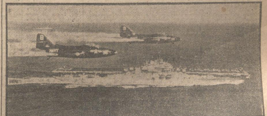
Aviones "F9F Panther", procedentes de realizar una misión en Corea, se desprenden de gasolina antes de posarse sobre la cubierta del portaaviones "Princeton". El exceso de gasolina resulta peligroso, pues puede provocar un incendio al aterrizar. (Fot. P. A.)
