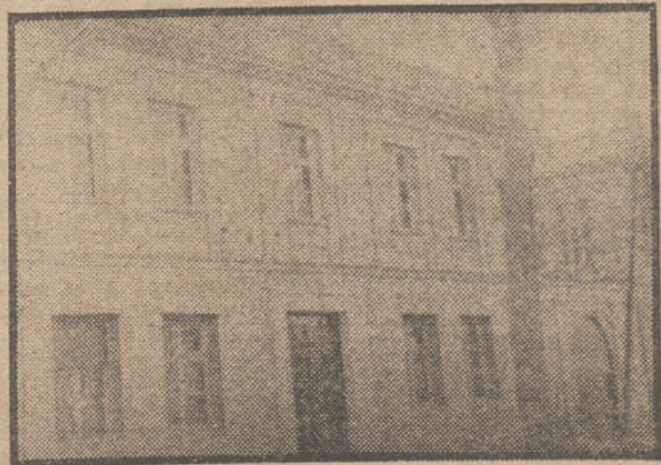
Fachada principal del nuevo dispensario antituberculoso, en la avenida de Calvo Sotelo, que será inaugurado mañana por el director general de Sanidad, doctor Palanca. — (Fot. SANZ).
