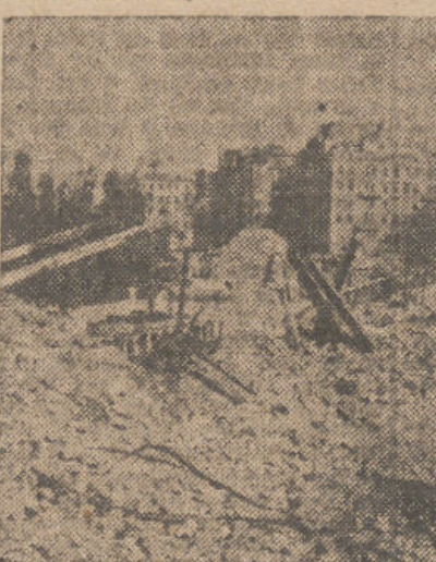
Montones de escombros llenaban las calles de la antaño brillante capital austriaca en el momento de producirse su "liberación", en los últimos tiempos de la guerra. La tarea de descombrar requirió largos meses antes de que la ciudad se abriera de nuevo al tráfico normal. (Fot. ARCHIVO).
