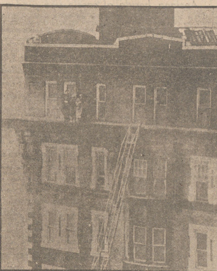
Más de la mitad de este hotel de siete pisos fue destruido por un incendio en Atlantic City. Cuatro huéspedes esperan sobre una cornisa la llegada del bombero salvador. Afortunadamente, pese a todas las peligrosas peripicias, no hubo víctimas. — (Fot. A. P.)
