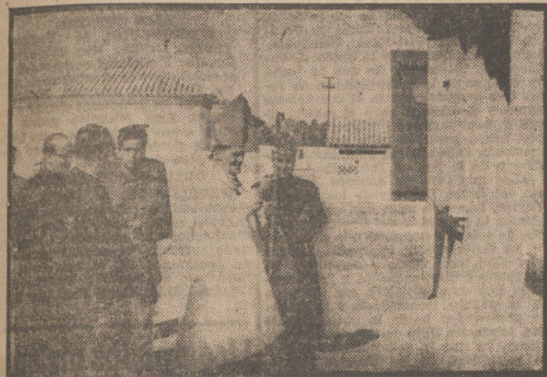
El doctor Muñoz, durante la bendición de viviendas, en la Base aérea de Armilla.—(Fot. SANZ).
