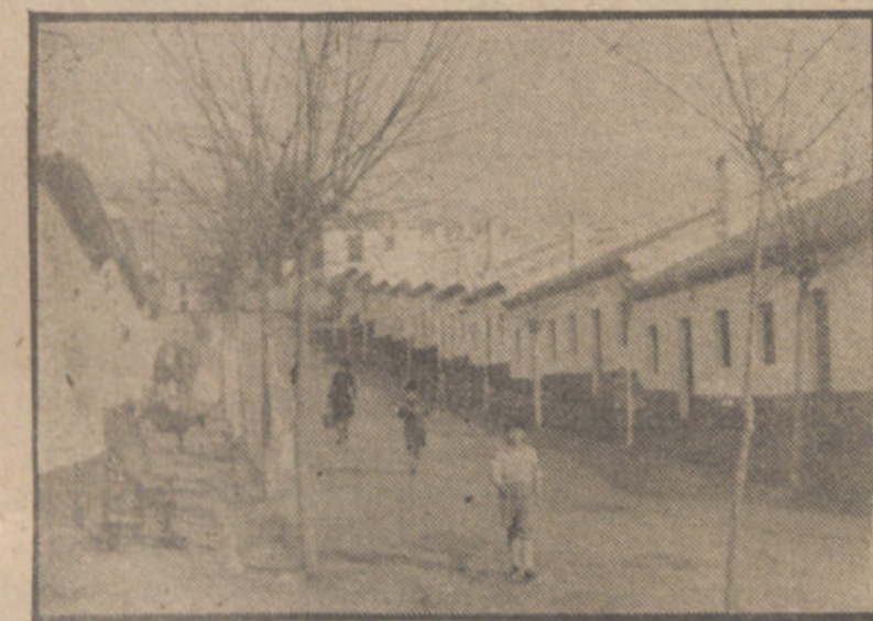
Vista de la barriada de veinticinco casas, edificadas por el Patronato de Santa Adela en Pulianas.
