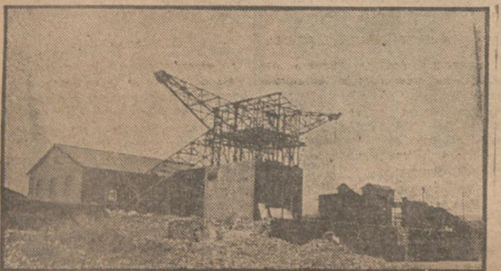
Vista de una fase de montaje de una estructura metálica para transporte y carga de minerales, obra de los Talleres "TAMESE".
