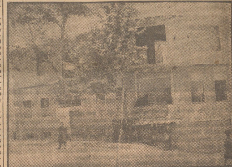
Vista de las obras de la nueva sucursal del Hotel Nacional donde va instalado el garage.
