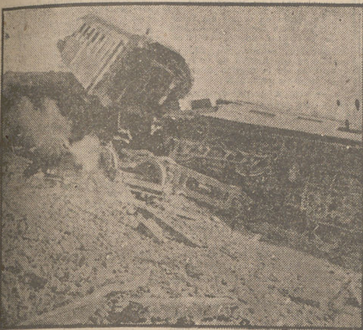
He aquí el impresionante estado en que quedó parte del expreso Málaga-Madrid que descarriló el pasado domingo entre las estaciones de Puente Genil y Casariche.
