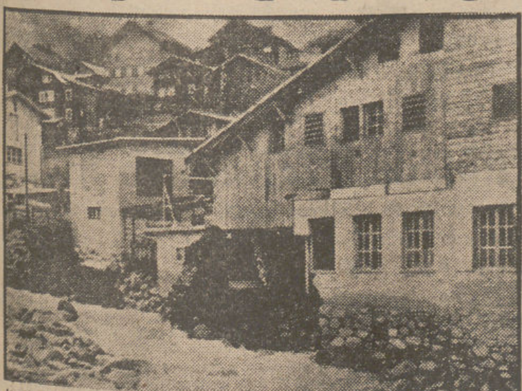
La ciudad de Disentis, en Suiza, ha sido gravemente afectada por las inundaciones que han desencadenado las últimas lluvias. Es la más violenta del Rhin desde el año 1927. Muestra la foto una casa con la esquina partida por la fuerza del temporal.
