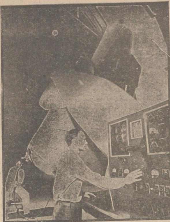
El reflector Hale, el mayor telescopio del mundo, de 5,08 metros, que se encuentra instalado en Monte Palomar, a un centenar de kilómetros al Norte de San Diego (California). Con este telescopio, que pesa 530 toneladas, se pueden ver estrellas que distan mil millones de años de luz.
