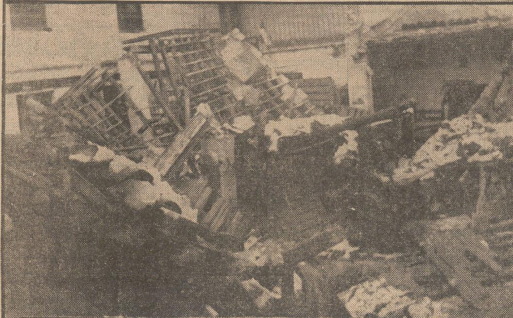
A consecuencia del peso de la nieve, en la misma noche del sábado, se derrumbó una fábrica de curtidos, sita en la calle de Moral Alta, arrastrando también los muros de contención. La fotografía muestra un aspecto del edificio, que quedó completamente destruido.—(Fot. SANZ).
