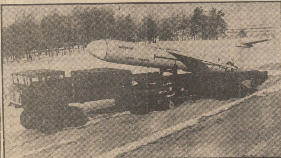
He aquí el TM-61B, el proyectil norteamericano dirigido segundo de la serie «Matador», construido por Martin de Baltimore. Sus alas miden siete metros y medio, aproximadamente, y su longitud es de más de catorce metros. Va equipado de un motor de propulsión Allison J-33 y alcanza una velocidad de 650 millas a la hora. Como puede observarse, ha sido necesario construir un vehículo de características especiales para su traslado y desembarque.—(Fot. CIFRA GRAFICA).
