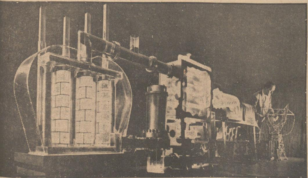
He aquí el modelo de reactor nuclear construido por la Westinghouse Electric Corporation, acoplado a un generador eléctrico y al equipo de distribución. El combustible nuclear, contenido en la estructura de la izquierda, produce calor que convierte en vapor el agua, y el vapor mueve la turbina de la derecha.—(Fot. USIS).
