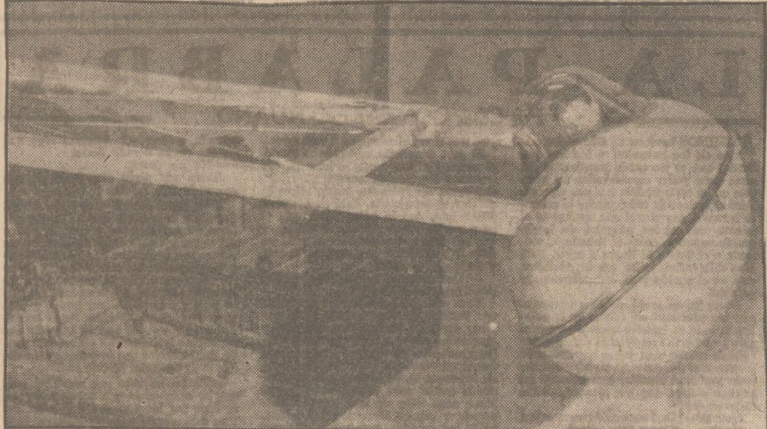
Este aparato que aquí presentamos está destinado a servir de pruebas a los pilotos del futuro. Ha sido instalado en el Instituto del Aire y Medicina de Bonn y, en dos segundos, alcanza una velocidad cuatro veces superior a la aceleración de la Tierra, o sea, 84 rotaciones por minuto.—(Fot. A. P.)
