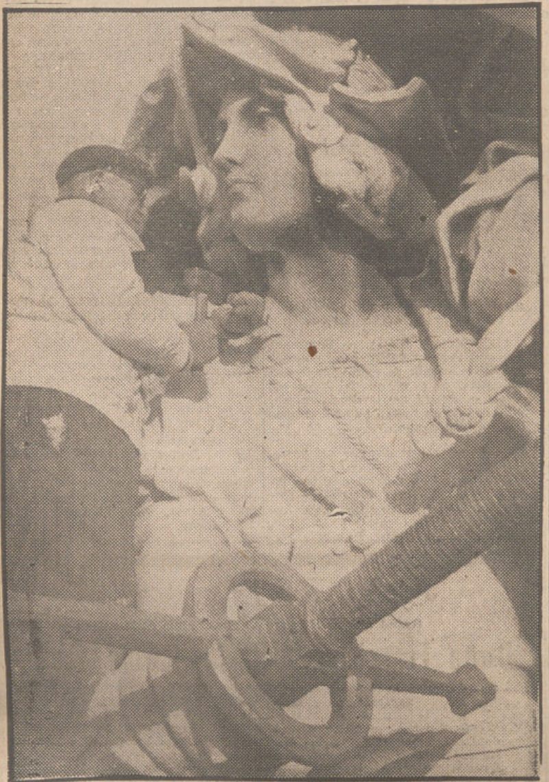
En París se preparan para recibir la primavera y como todos los años se limpian y restauran sus célebres puentes. En la foto vemos un trabajador en el puente de Alexander III que une Invalidos con Champs Elyses y que está siendo con cuidado reparado de los daños producidos por los frios y aguas. (Fot. KEYSTONE).
