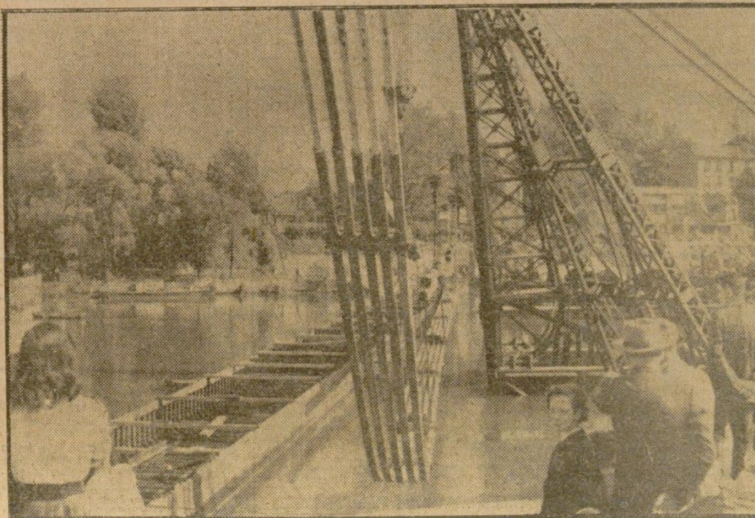
A fin de permitir la inmersión en el Sena de cables eléctricos que favorezca el suministro de energía por debajo del río, ha sido interrumpida la navegación desde Neuilly a Levallois. La fotografía recoge un momento de la colocación de los cables de acero. — (Fot. KE YSTONE).
