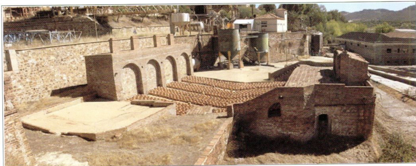
Fig. 2. Hornos Bustamante, usados para la destilación de mercurio. Parque Minero de Almadén, Ciudad Real.
