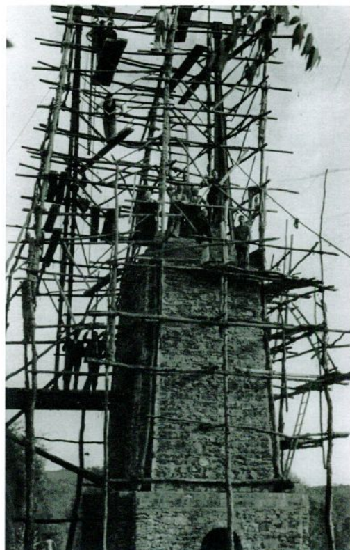
Estructura portante del monumento a base de mampostería y ladrillos cerámicos. Se observan los tres cuerpos perfectamente definidos, a falta del revestido y de la colocación de la imagen del Sagrado Corazón de Jesús. Es de reseñar el entramado de andamiaje de madera. (Fotografía cedida por la familia Pinedo Caballero)
