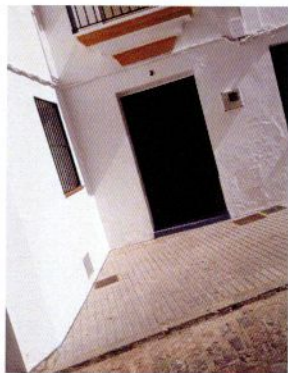
Perfil de puerta y fachada en inmueble cerca del Pilar Largo.
