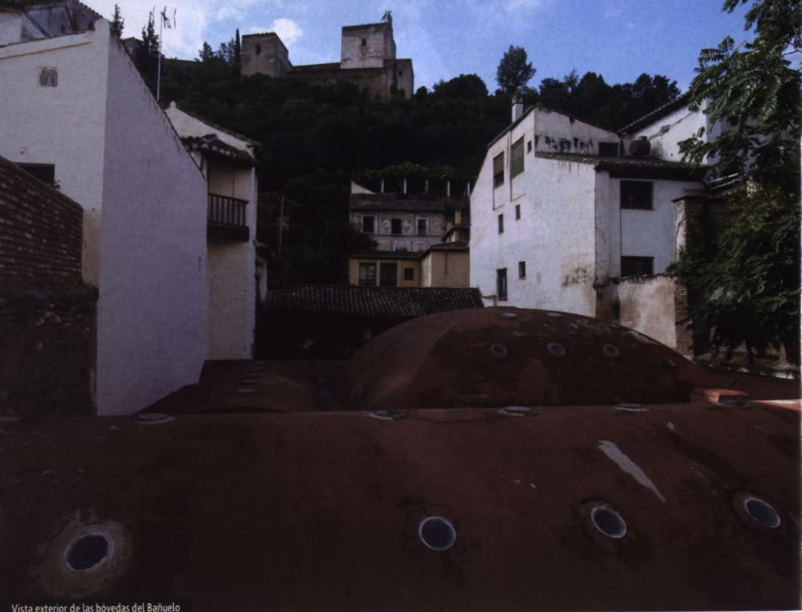
Vista exterior de las bóvedas del Bañuelo
