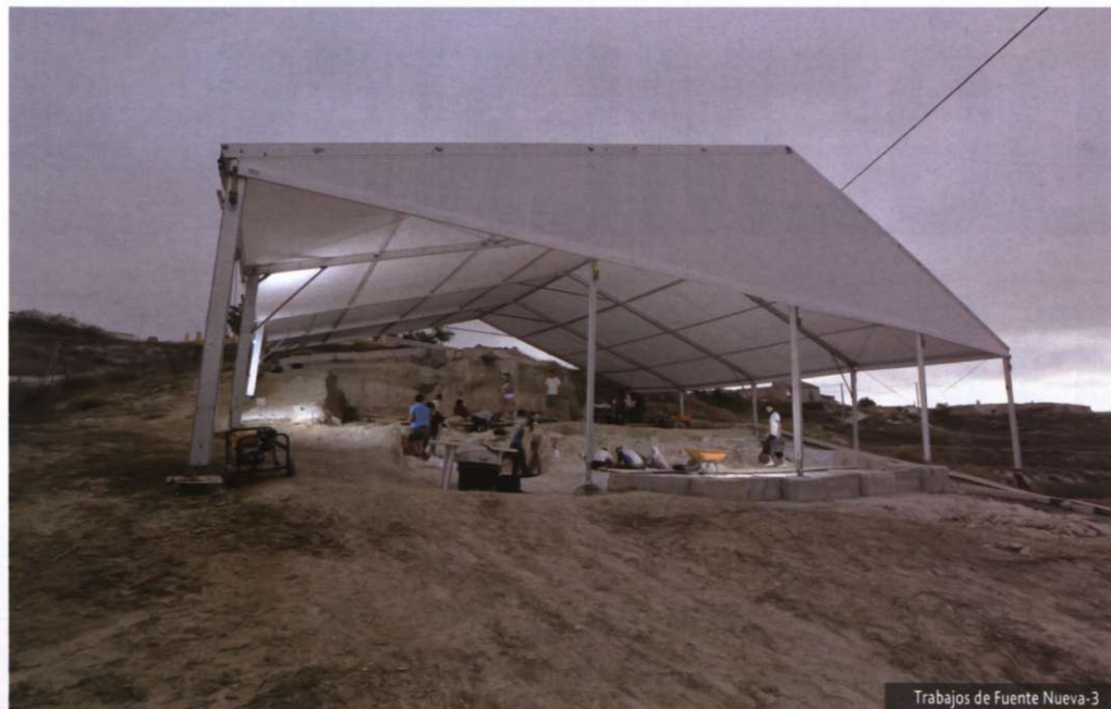
Trabajos de Fuente Nueva-3
