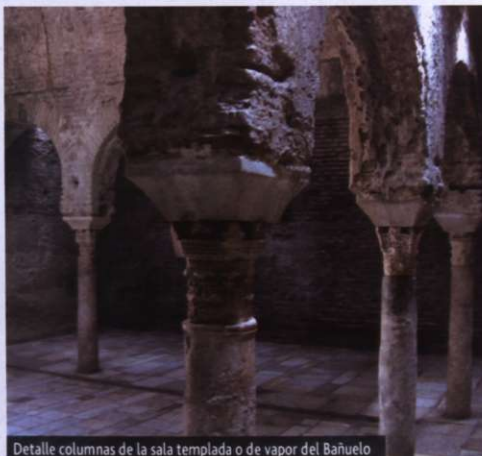
Detalle columnas de la sala templada o de vapor del Bañuelo
