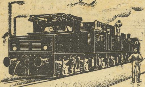
fué construida por SIEMENS para el servicio en las minas alemanas de carbón fósil. Tiene 6 motores de tracción, que con corriente continua de 1.200 voltios dan un rendimiento de 1.560 kilowatios. (Esta locomotora es capaz de transportar en una sola carga la cantidad de tierra equivalente al volumen de una casa mediana).
