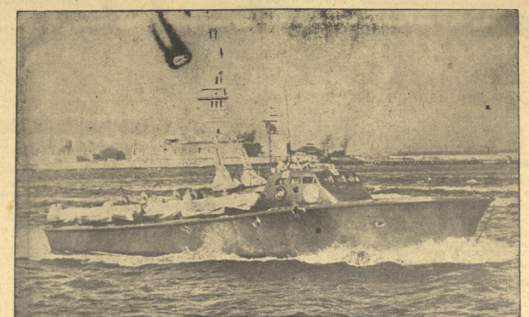
LANCHAS TORPEDERAS NORTEAMERICANAS.—Llevan cuatro ametralladoras del calibre 50, cuatro tubos lanzatorpedos de 18 pulgadas, y una tripulación de ocho hombres. Alcanzan 70 nudos por hora. El coste de cada una de estas lanchas asciende a 150.000 dólares. (Foto Cifra).
