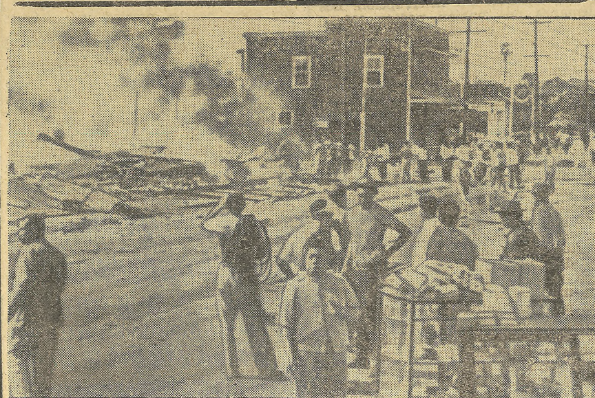
Los efectos causados por las bombas japonesas en Hawaii. En este lugar había antes un gran almacén de existencias, que ha sido incendiado por completo por las bombas de la aviación japonesa. Los edificios de los alrededores sufrieron también los efectos de las llamas y el incendio sólo pudo apagarse después de muchos esfuerzos. (Foto Orbis)
