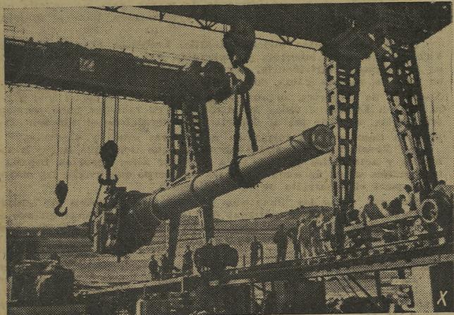
Trabajos de defensa en la costa del Canal que se lleva a cabo por la organización Todt alemana. Por medio de una grúa es transportado el pesado tubo de cañón al lugar de emplazamiento. (Foto Trasocean)
