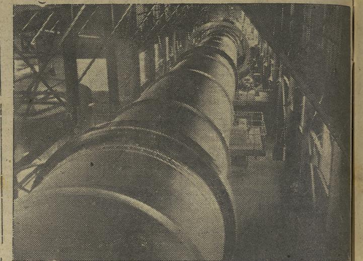
El horno de 270 pies de la nueva instalación de reducción de la Anaconda Copper Mining Co., produce 300 toneladas diarias de riñones de óxido de manganeso. El carbonato de manganeso finamente molido entra por un extremo de la enorme caldera productora y sale por el otro, listo para ser utilizado en la producción de acero.
