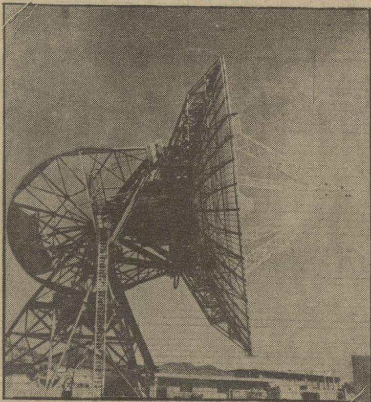
Esta es la gran antena parabólica de veintiséis metros de diámetro y doscientas cincuenta toneladas de peso, de la Estación Espacial de Robledo de Chavela, con la que se reciben las señales del «Lunar Orbiter» y las fotografías que transmite. — (Telefoto EUROPA PRESS)
