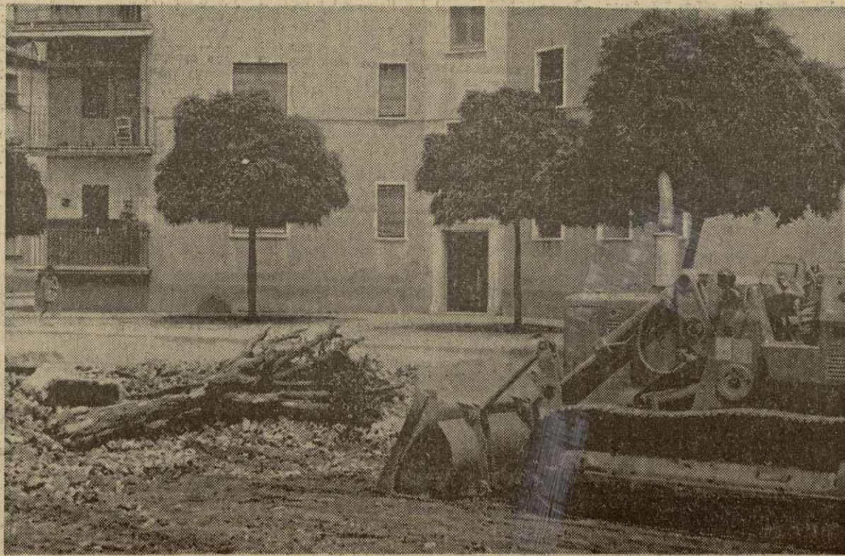
Siguen las obras de pavimentación de la Avenida de Dilar y para que todo salga bien, pronto se recurre a los más expeditivos medios, como éste que muestra la foto de Ferrer de la «cavadora «segando» árboles, que resulta ser un espectáculo interesante para no tener otra cosa que hacer.
