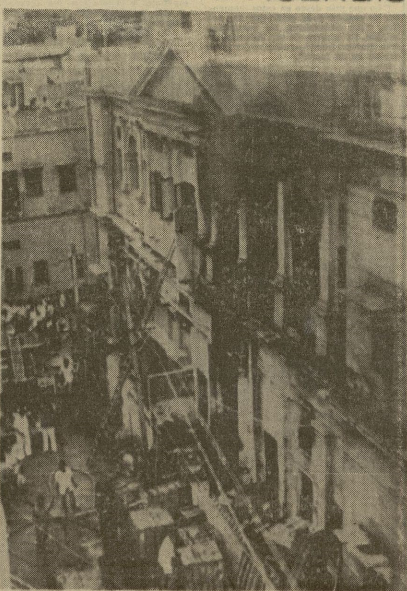
Un aspecto del incendio a causa de la explosión de unas botellas de gas en el edificio de la localidad de Daryagumj (India), donde se almacenaban. Diecisiete personas resultaron muertas y otras cincuenta heridas, cuando el fuego se propagó por todo el edificio, a causa de la explosión. — (Telefoto UPI-CIFRA)
