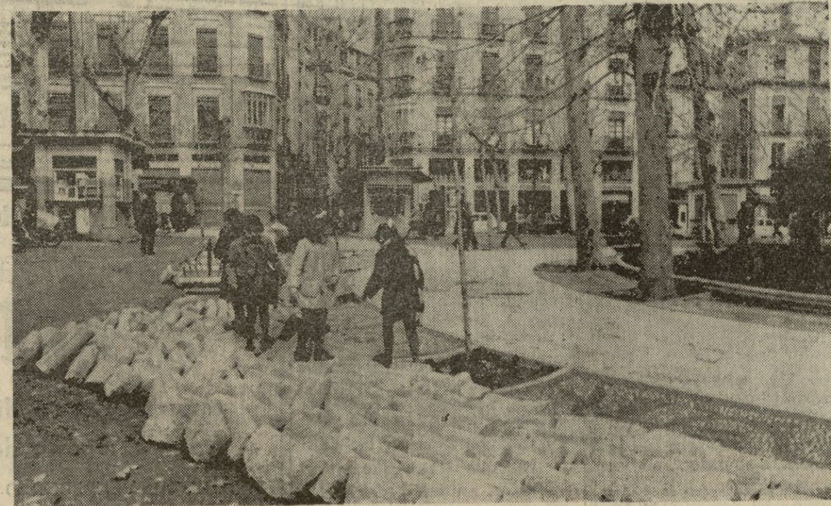
Van a comenzar las obras de urbanización de la Plaza de la Trinidad. Todo está disponiéndose para que los trabajos se inicien seguidamente. Ayer se arrimaron los bordillos para que el proyecto, del que PATRIA ofreció la primera noticia, hace un par de meses, sea una realidad inmediata. La noticia está ahí, con su testimonio gráfico de Ferrer.
