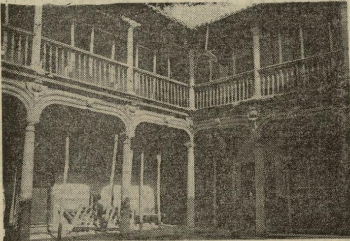
Patio del palacio. En el proyecto está previsto realizar obras de consolidación y restauración, ya que se encuentra en mal estado. Su tratamiento técnico consiste en desmontarlo completamente y volverlo a montar.
