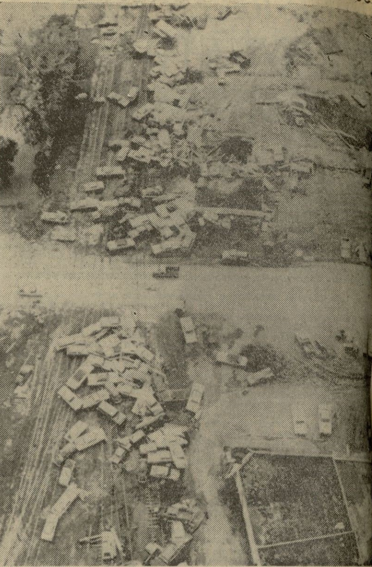
Según un comunicado oficial, ciento cincuenta y cinco muertos y numerosos desaparecidos, es el triste balance de las inundaciones que han asolado la localidad de Rapid City. Grandes zonas de la ciudad han quedado totalmente anegadas por el agua a consecuencia de las lluvias torrenciales caídas en la zona. Todas las comunicaciones telefónicas, de electricidad y algunas por ferrocarril y carretera están cortadas. En la foto, extensas áreas de la ciudad aparecen cubiertas por las aguas. — (Telefoto CIFRA GRAFICA)
