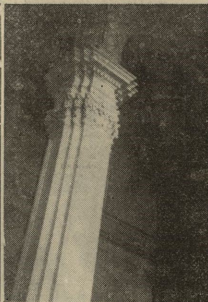
Uno de los pilares interiores donde Siloé prescinde de las columnas adosadas que utiliza en la catedral de Granada. Sencillo, pero de una limpieza clásica admirable. — (Foto MOLERO)
