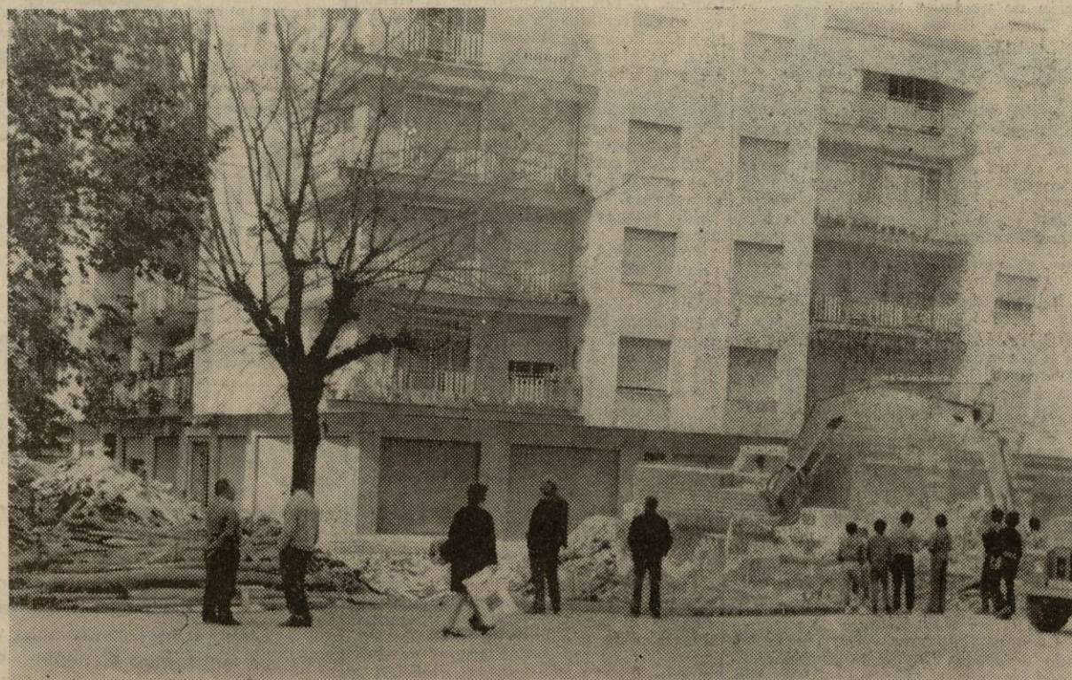
Desaparecieron, por fin, las casillas de Torremocha, situadas entre las avenidas de Dilar y de Cádiz, en la populosa barriada del Zaidín. Una máquina dio al traste con los enfebles inmuebles y en día y medio todo ha quedado como se representa en el grabado. Mientras la máquina procede a la demolición, gru- pos de curiosos dicen adiós a las casillas, entre sus restos de maderas y cascotes. — (Foto FERRER)
