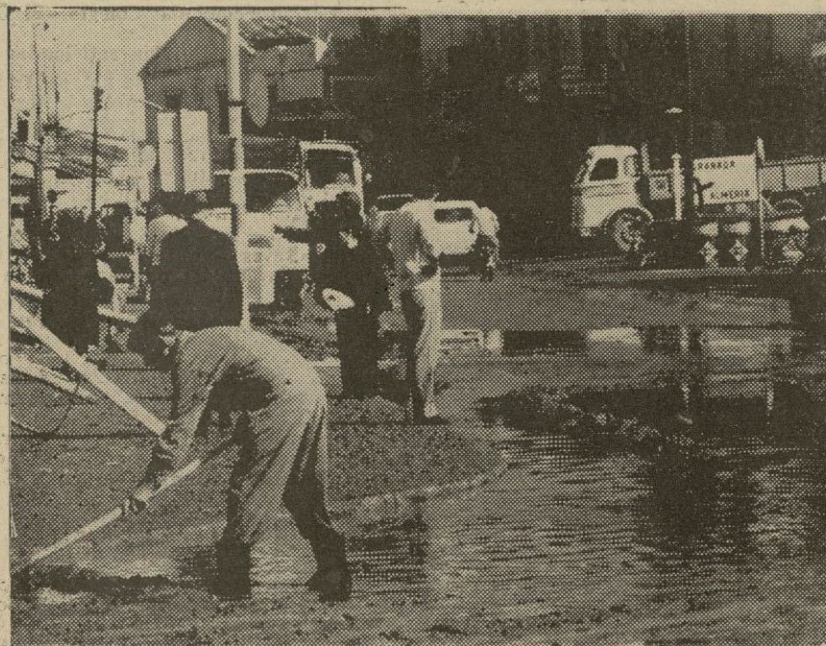
Aspecto de la Avenida del General Sanjurjo, en donde trabajan incesantemente brigadas municipales. — (Foto PENA)
