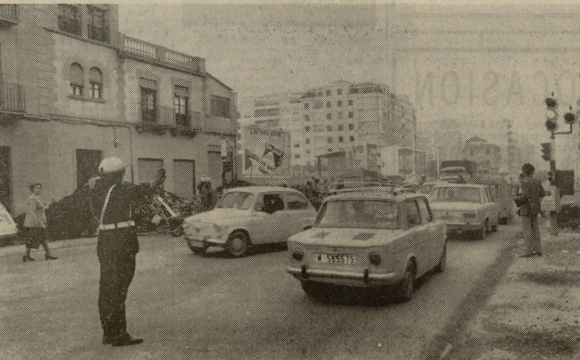
Aspecto parcial del estado en que quedó el trozo de cien metros pavimentado en el Camino de Ronda, como prueba del aglomerado asfáltico en caliente sobre el adoquín de la importante vía.—(F. FERRER)
