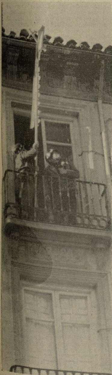
Una de las innumerables salidas de los bomberos motivadas por el viento que soportó la ciudad. Aquí les vemos quitando una cornisa que amenazaba peligro en la Carrera del Genil. — (Foto FERRER)
