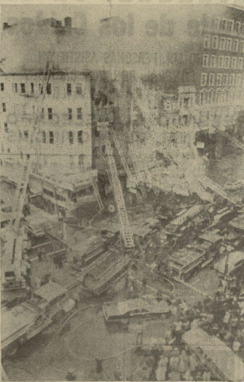
Una gran cantidad de material contra incendios y doscientos bomberos fueron empleados para combatir el fuego declarado en ese edificio situado en la esquina de las calles Boylston y Berkley, en Boston, en el que estaban los consulados de Israel e Irlanda. Pese al despliegue de medios, no pudo evitarse que el edificio quedara destruido. — (Telefoto CIFRA GRAFICA-UPI).
