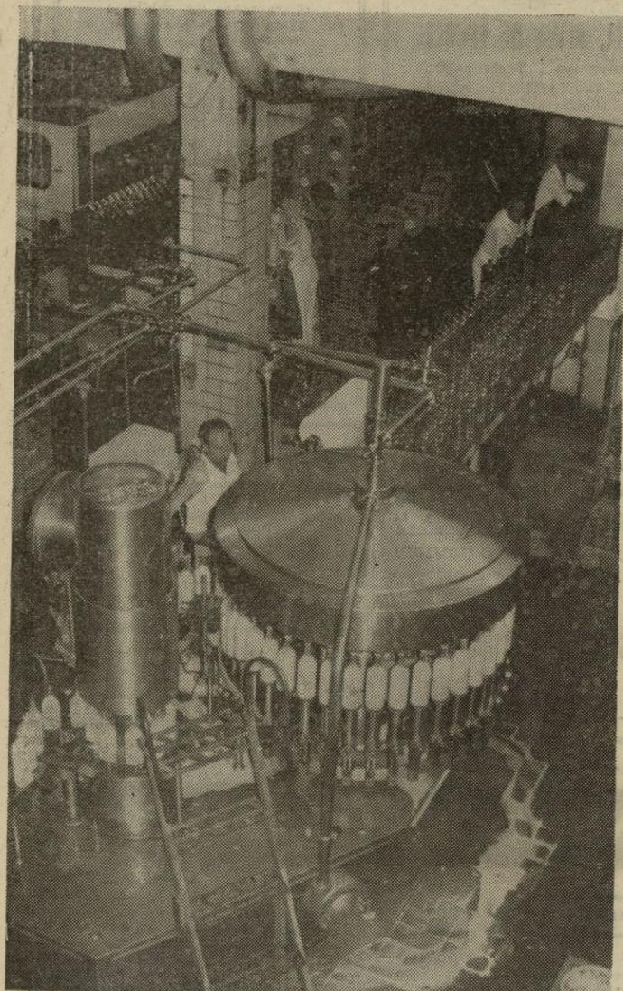
La lechera de botellas va surgiendo de la máquina embotelladora que distribuye el alimento líquido por excelencia después de ser convenientemente tratado. La mecanización es muy alta y evita todo contacto humano con la leche. En las nuevas instalaciones la automatización será máxima, para convertir la central lechera de Granada en la más moderna de Europa. (Foto FERRER).
