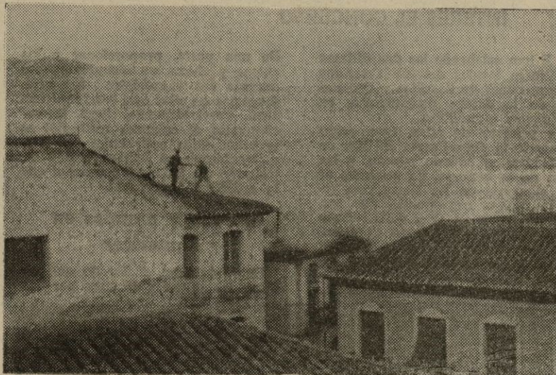
Muy importante fue el incendio que se declaró en la tarde del domingo en Baza y que destruyó casi por completo la vivienda de su alcalde señor Ferre Ferre. En la fotografía, las llamas y el humo hacen su aparición por encima de los tejados colindantes.
