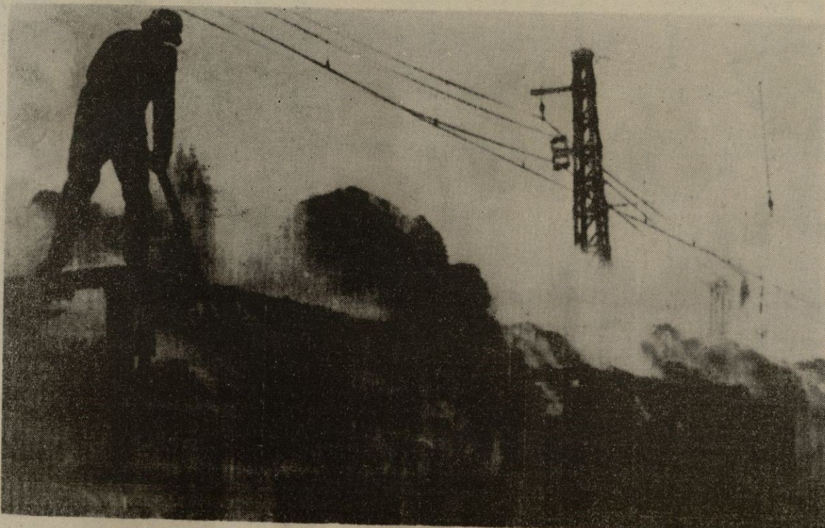
Cinco vagones, cargados de paja, de un tren de mercancías quedaron destruidos por el fuego en la estación de El Pinar de las Rozas, en las cercanías de Madrid. Al parecer, el tren resultó alcanzado por las llamas de una zona próxima a la vía que estaba ardiendo. — (Telefoto CIFRA GRAFICA)
