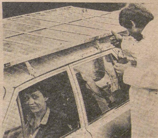
FRANCFORT (Alemania Federal). — Células solares colocadas en el techo del vehículo, cargan la batería del coche y ayudan a la dinamo, reduciendo el consumo de gasolina en un cinco por ciento. El sistema está a prueba en el departamento de investigaciones de la compañía eléctrica AEG-Telefunken. (Telefoto Efe-Upi).
