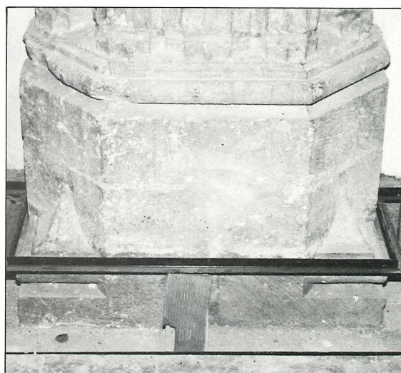
Excavación en torno a las columnas para ver el basamento completo.
