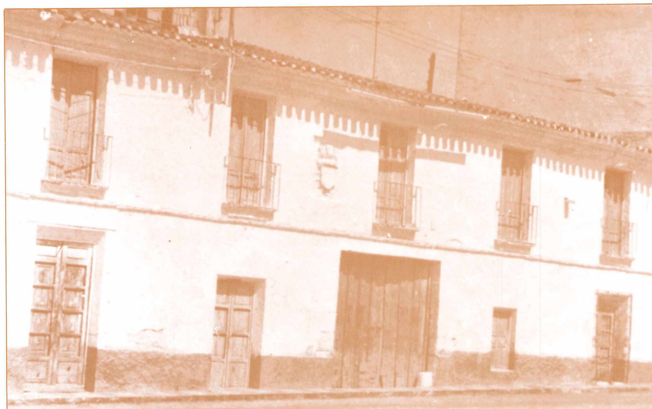
El Mesón del Marqués ó "Posada del Mesón" poco antes de su derribo.
