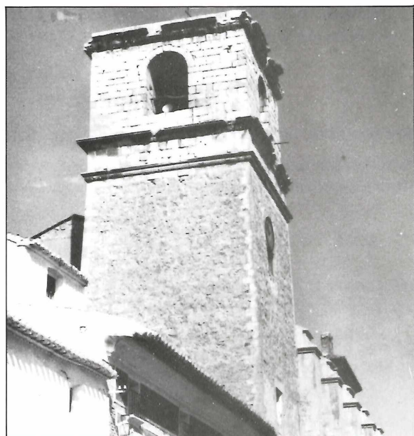
Torre de la iglesia antes y después de su restauración.
