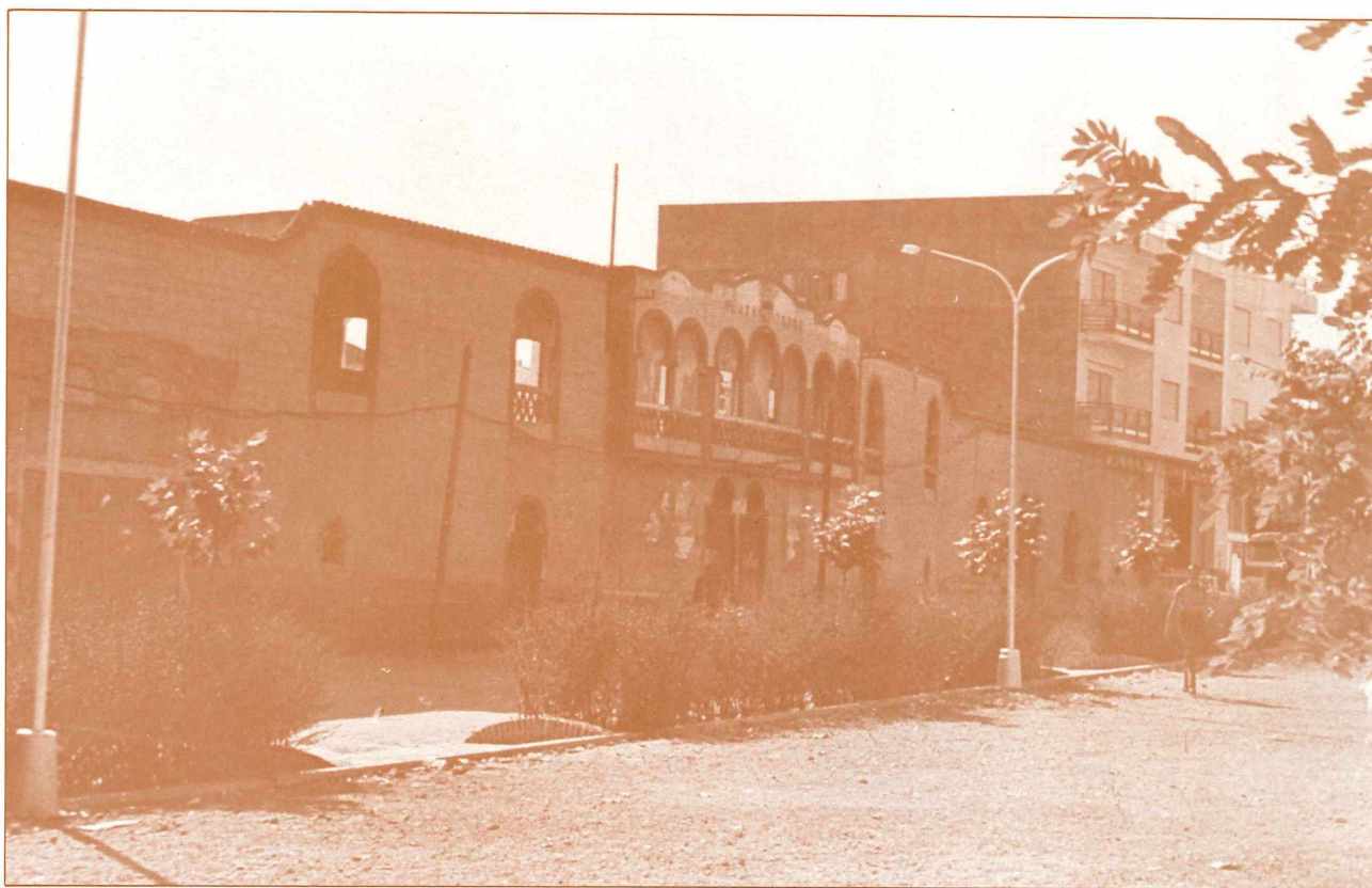
Momentos en los que se procedía a su derribo.
