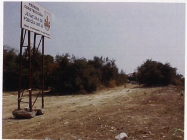
Interior del solar con una superficie de unos 2.000 metros cuadrados.
