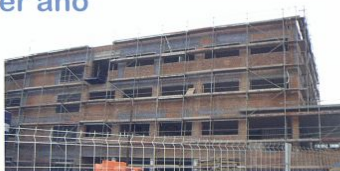
Nuestro edificio en obras
