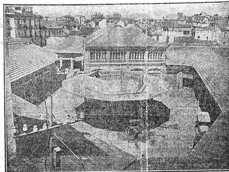
Vista general del «Garage Alhambra»
