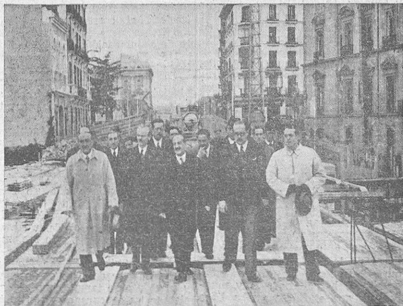
Los ministros de Gobernación y Obras Públicas con el alcalde señor Alcocer y otras autoridades e ingenieros, han visitado las obras del viaducto madrileño. Han sido los primeros en cruzarlo, ya cubierta la vía, y las obras estarán terminadas dentro del mes en curso. (Cifra.)
