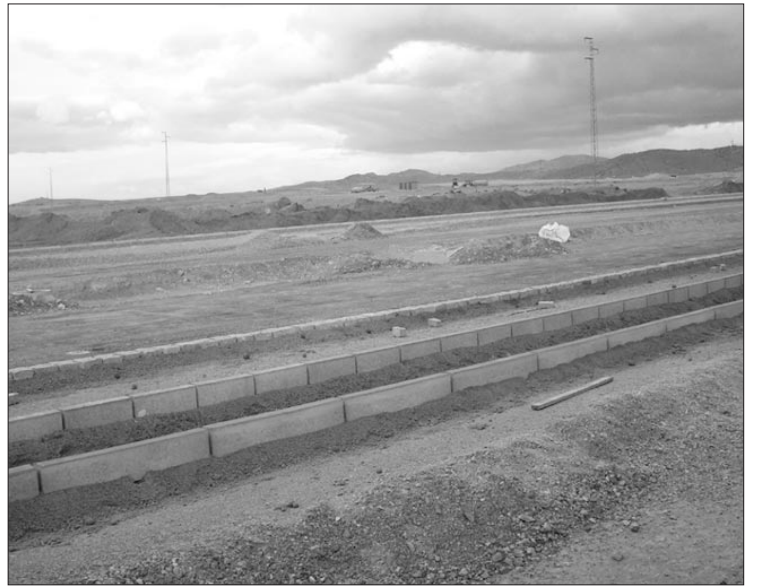
Acerados del segundo polígono.
