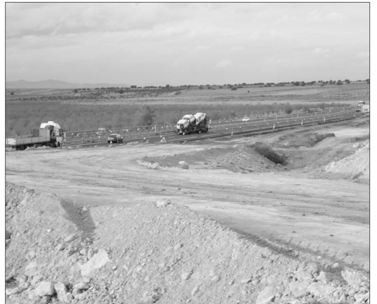
Nudo de enlace con la autovía.
